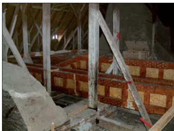
Lucrările de mansardare (2004-2005) Ausbau des Dachbodens (2004-2005)
