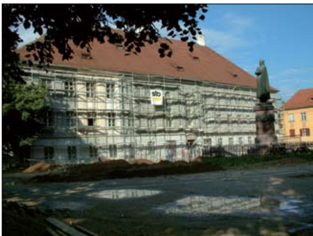
Renovarea fațadei clădirii școlii (2005) Renovierung der Fassade des Schulgebäudes (2005)
