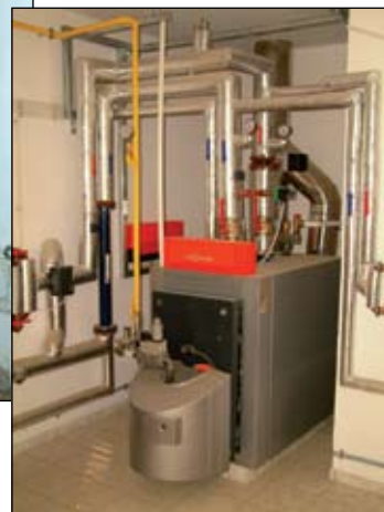
Punerea în funcțiune a noului sistem de încălzire (2005) Inbetriebnahme der neuen Heizungsanlage (2005)
