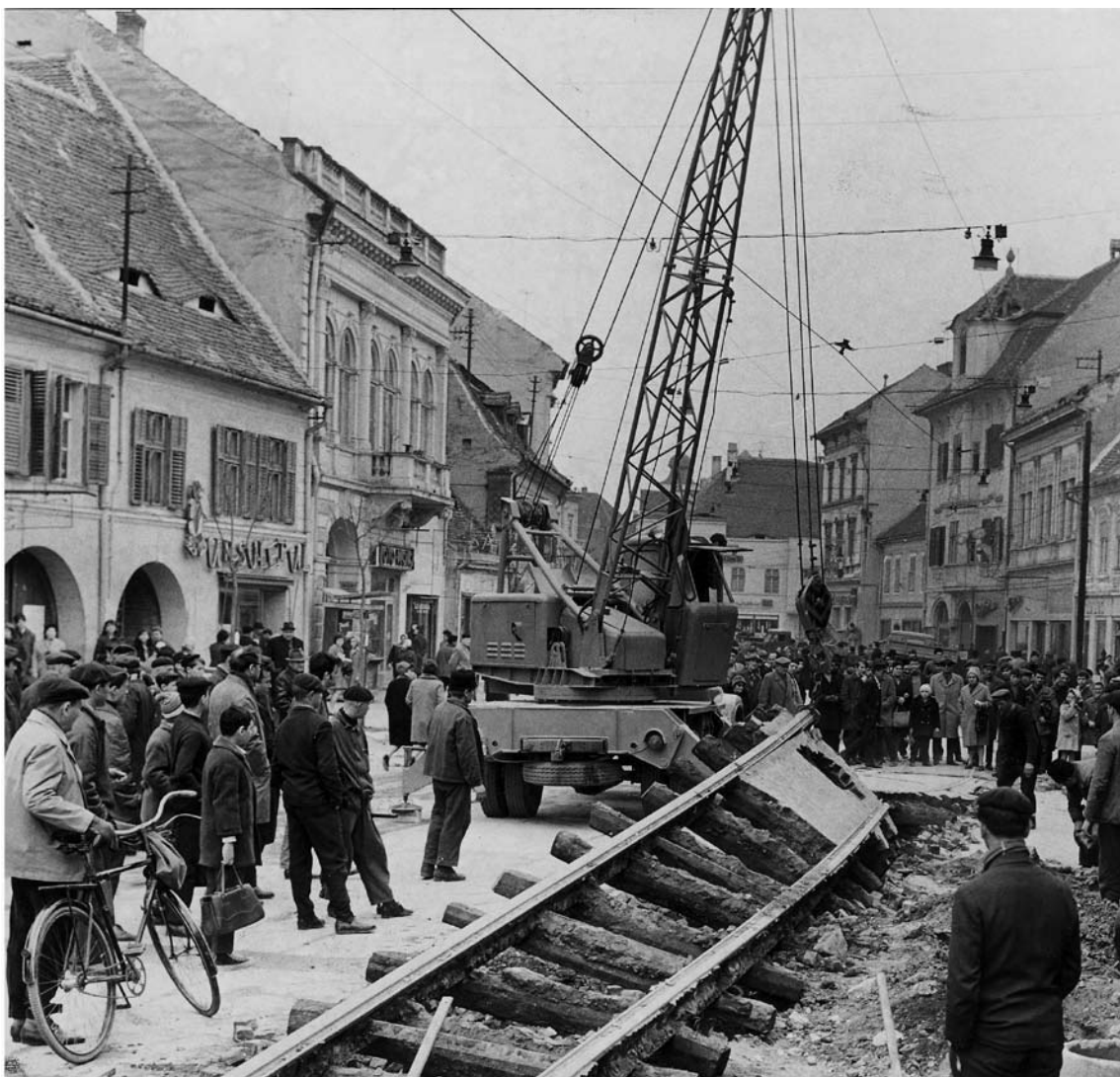
1970 in der Heltauergasse: Demontage der Straßenbahnschienen.
